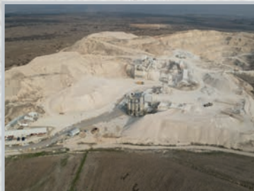
Yeşilçomlu Agregat Tesisi
