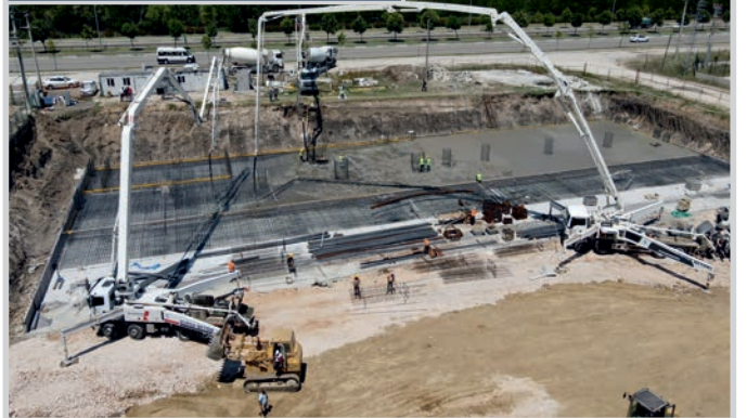
SELÇUK İNŞAAT-ECZA DEPOSU - BURSA
