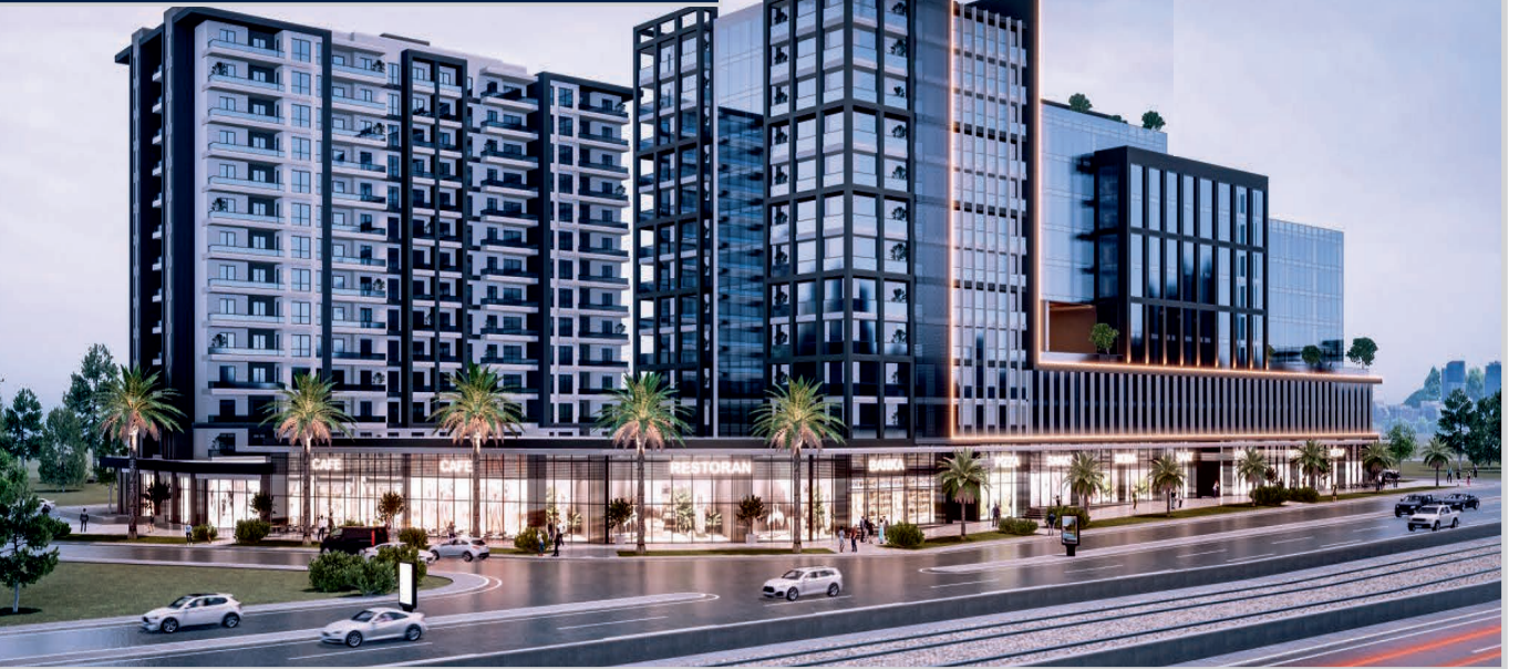
GÜLER CSK İNŞAAT - BURSA / BEŞYOL KENTSEL DÖNÜŞÜM PROJESİ
