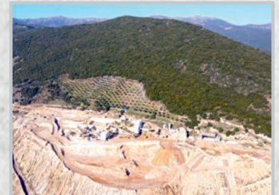
Cihatlı Agregat Tesisi
